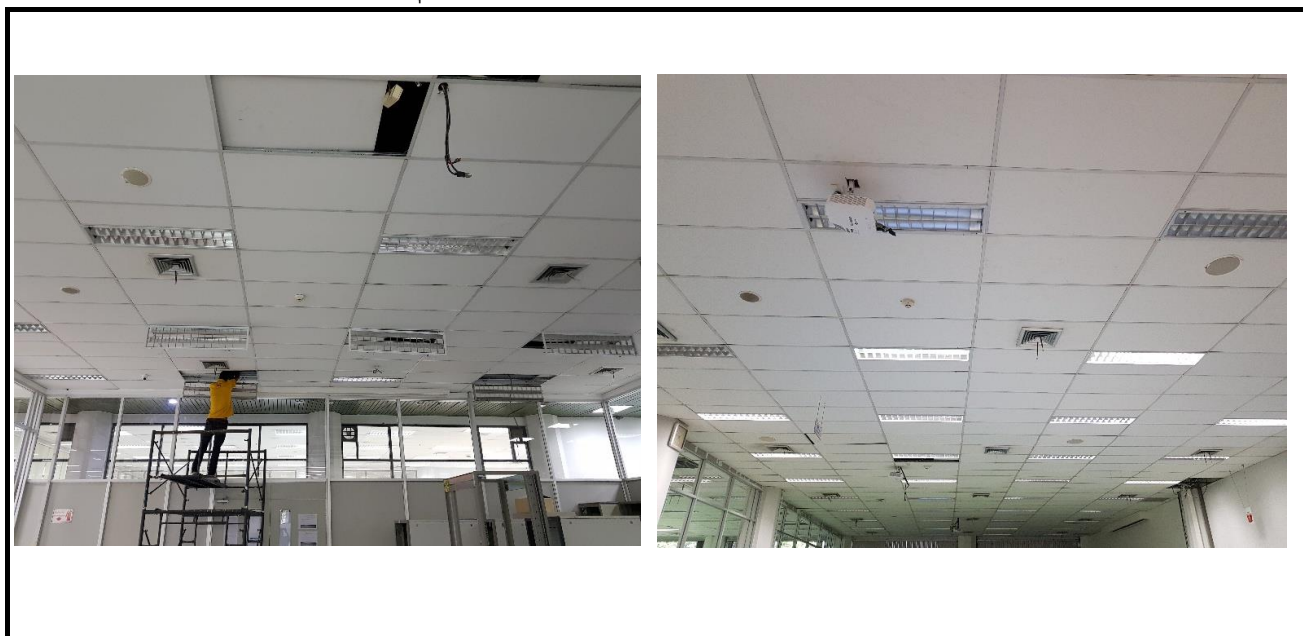
รูปที่ 6-4 หลังดำเนินการปรับปรุง
