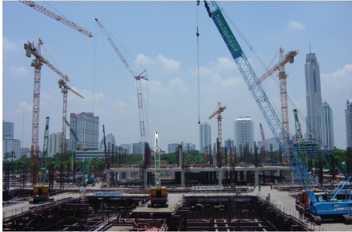
ภาพที่ 5.10 แสดงการก่อสร้างอาคาร
