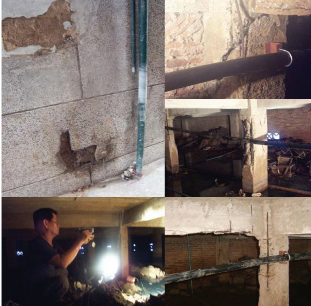
ภาพที่ 5.1 แสดงเสาและคานที่มีการกัดกร่อน
